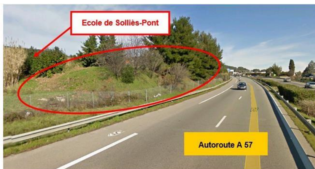
Illustration 4 : Mesure correctrice : merlon de protection (Solliès-Pont, autoroute A57)
