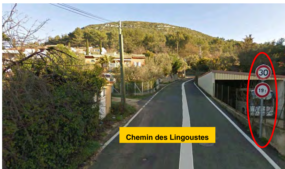
Mesure préventive : limitation des possibilités de circulation (Solliès-Toucas, chemin des Lingoustes)
