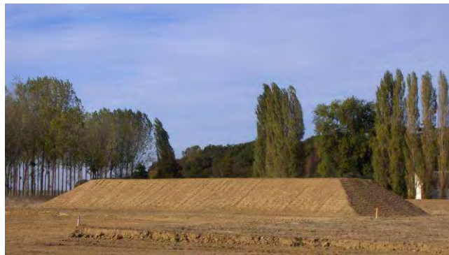
Mesure correctrice : merlon de terre devant des habitations
