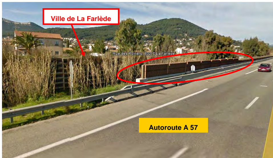
Mesure correctrice : écran acoustique devant un lotissement (La Farlède, A 57)
