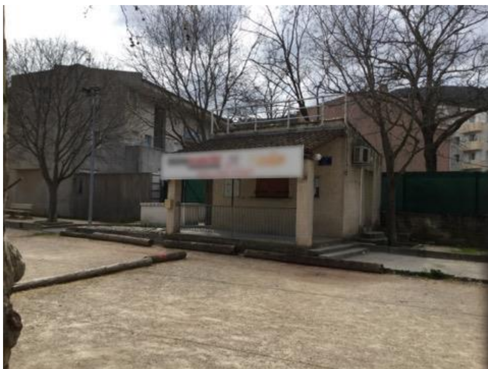
Publicité apposée sur mur dépassant les limites du mur et de l'égout du toit, Solliès-Pont, mars 2018
