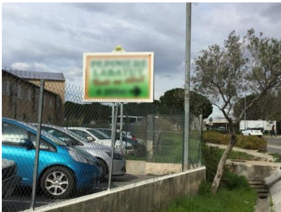
Publicité scellée au sol implantée à moins de la moitié de sa hauteur d'une limite séparative de propriété, Solliès-Pont, mars 2018
