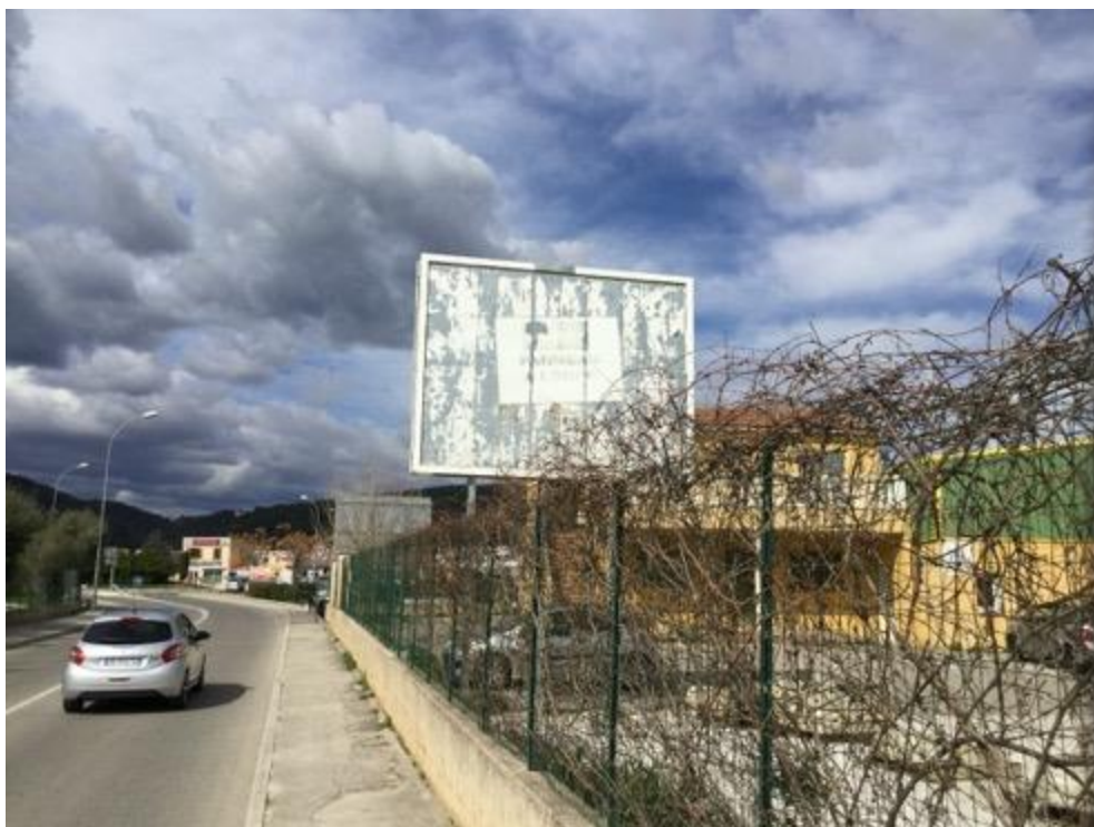
Publicité en mauvais état d'entretien, Solliès-Pont, mars 2018
