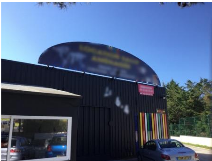
Enseigne sur toiture ou terrasse en tenant réalisée sans lettres découpées, Solliès-Pont, Mars 2018
