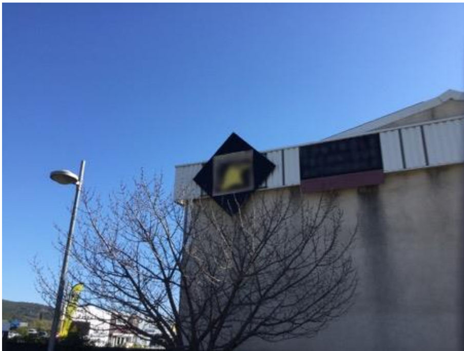
Enseigne qui dépasse des limites du mur, Solliès-Pont, Mars 2018
