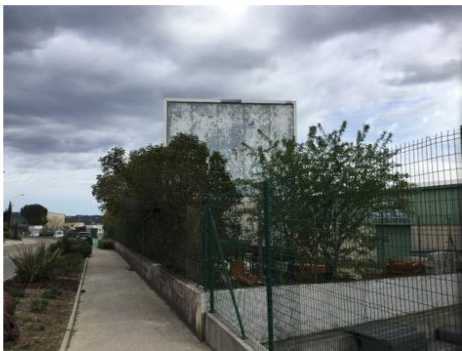
Publicité en mauvais état d'entretien, Solliès-Pont, mars 2018
