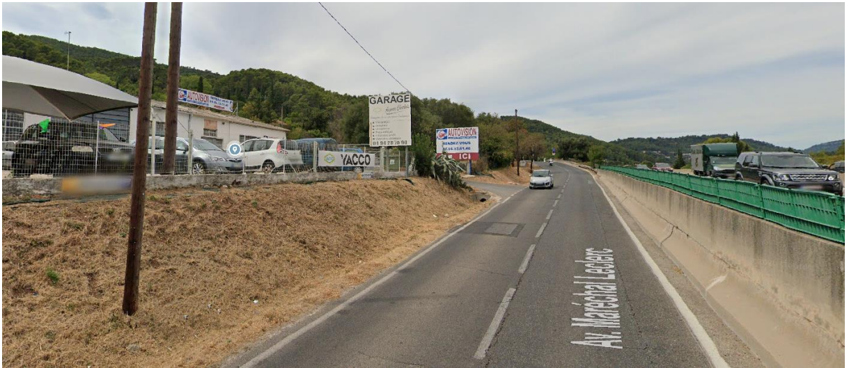
Avenue du Maréchal De Lattre (source : Google street view)
