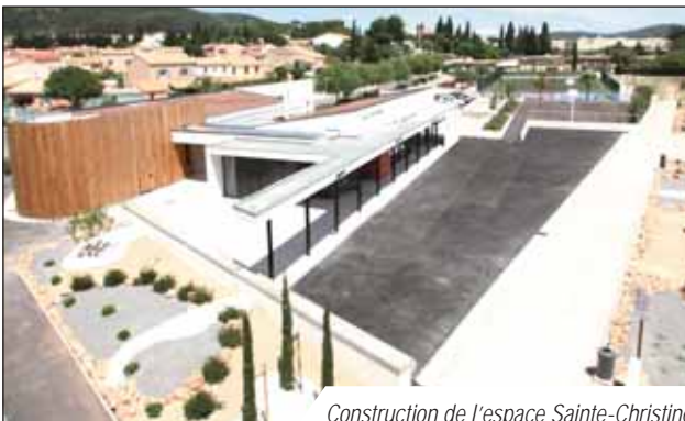
Construction de l'espace Sainte-Christine
