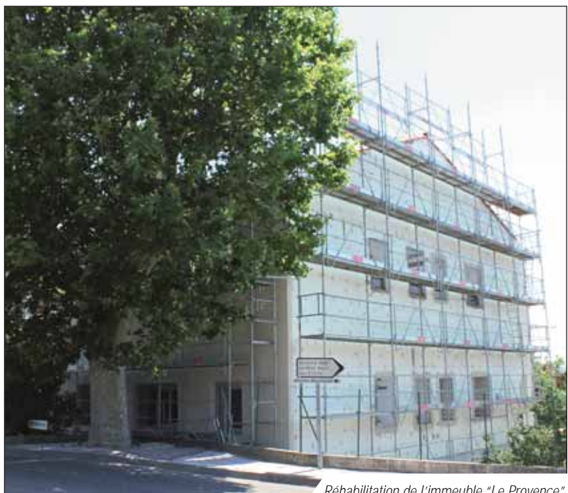
Réhabilitation de l'immeuble "Le Provence"
