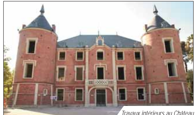
Travaux intérieurs au Château
