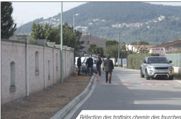
Réfection des trottoirs chemin des fourches
