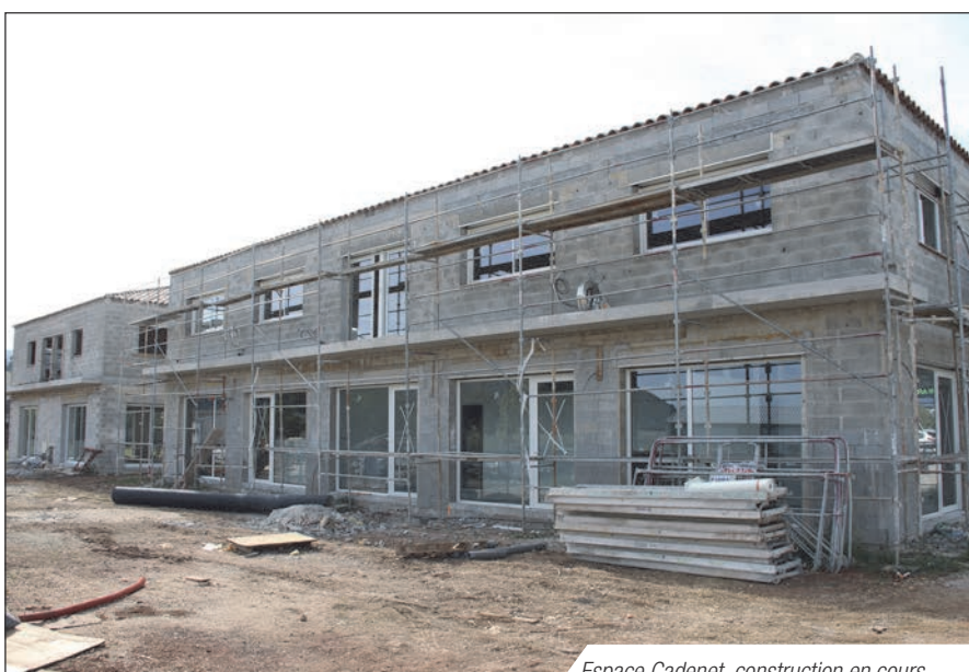
Espace Cadenet, construction en cours
