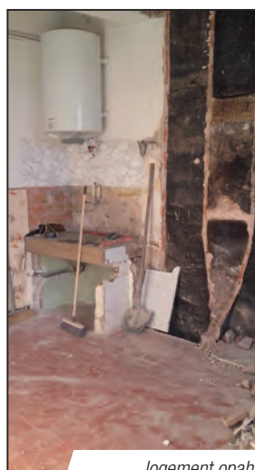
logement opah avant les travaux
