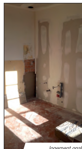
logement opah pendant les travaux
