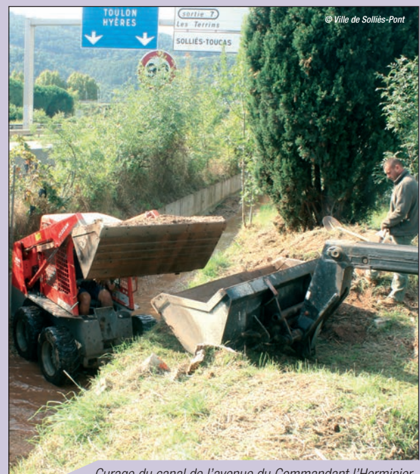
Curage du canal de l'avenue du Commandant l'Herminier
