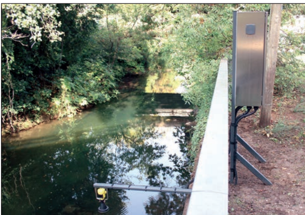
© Ville de Solliès-Pont
