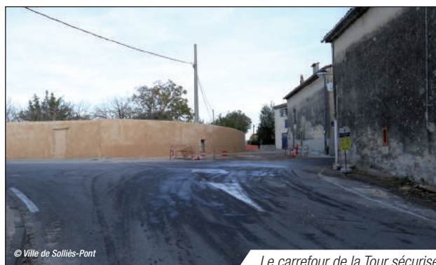
Le carrefour de la Tour sécurisé
