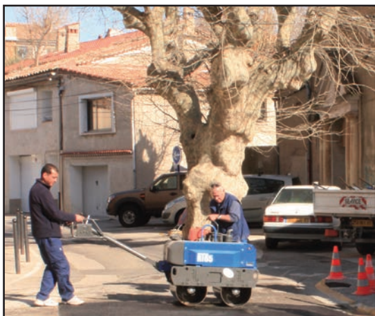
Réparation de voirie, devant la salle des fêtes, rue Lucien Simon
