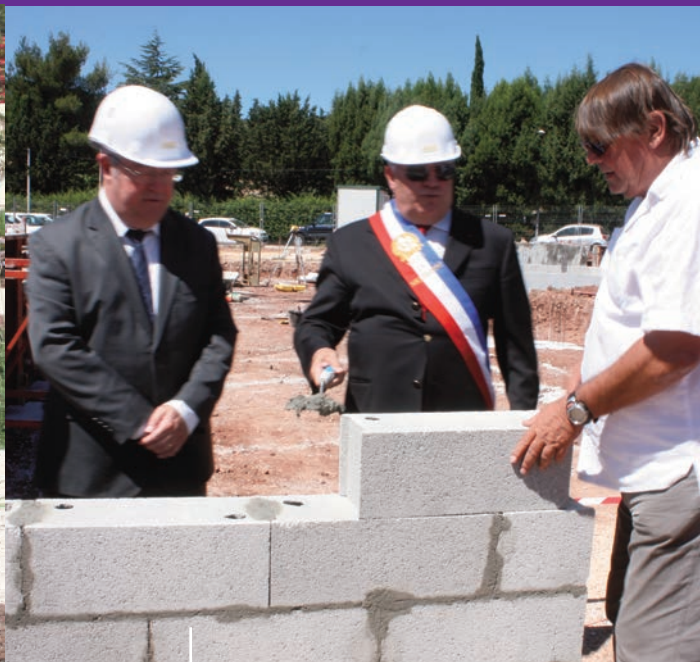
Pose de la première pierre de la maison de quartier Sainte Christine
