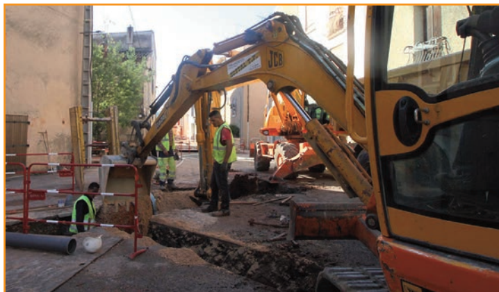
Enfouissement des réseaux avenue de la Gare
