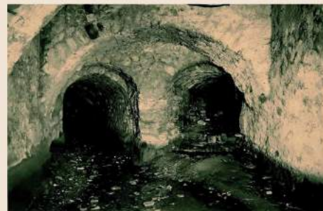
Vers l'amont, arrivée des eaux dans les Carcés
